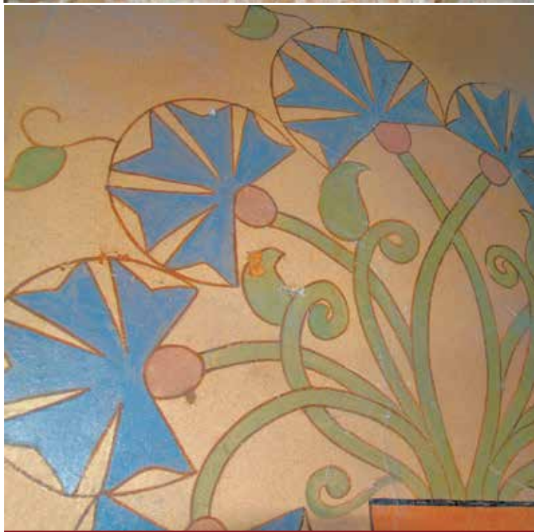
Руйнування фарбового шару розписів парадних сходів в будинку І. Бойка. Світлина В. Шуліки. 2021
