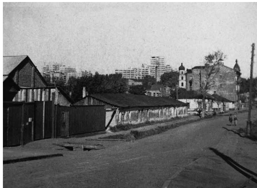
1930-ті рр., Харків. Стара забудова, вул. Іванівська
