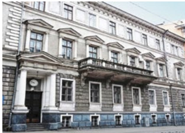
Будинок Тработті на вул. Гоголя, 16 (нині Одеський технікум промислової автоматики)
